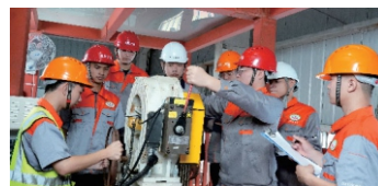
电梯安装与调试
